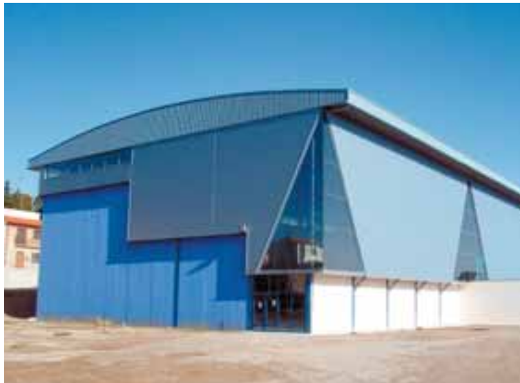
El frontón junto al que se construirá el nuevo edificio.
